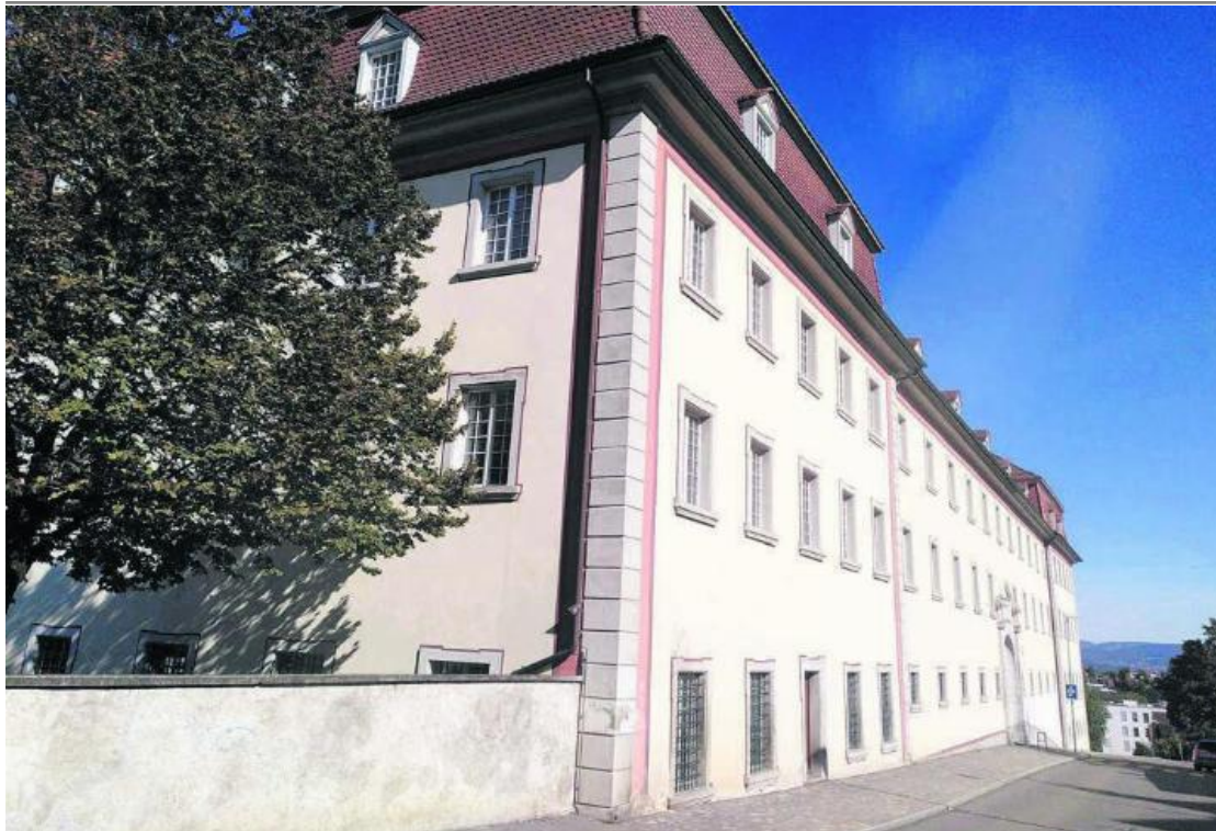
Die Grundeigentümer des Klosters kommen für ihre jeweiligen Gebäudeteile auf. Die Gemeinde Muri nimmt dabei unter anderem die Arbeiten am Südflügel vor. Bild: zg
