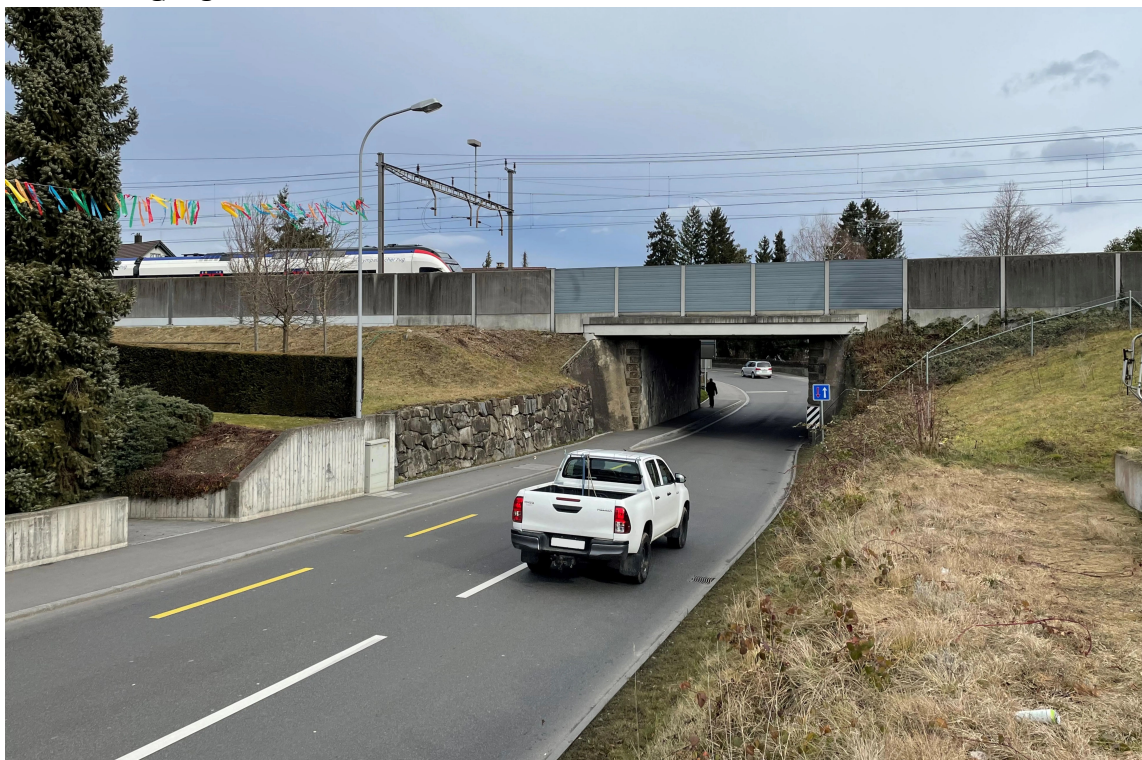
So sieht die SBB-Unterführung an der Zürcherstrasse in Muri heute aus: viel zu eng für alle
