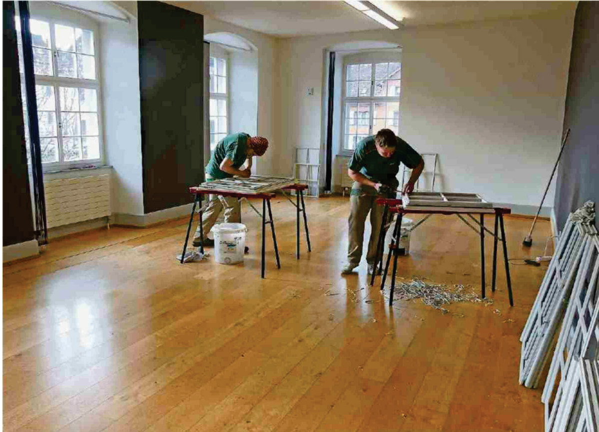
Die Handwerker sind an der Arbeit und montieren die speziellen Fenster im künftigen Museum Caspar Wolf. EDDY SCHAMBRON
