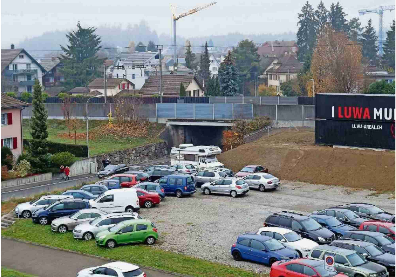
Über die Zürcherstrasse gibt es neben der SBB-Brücke für den Rad- und Fussgängerweg eine separate Brücke. EDDY SCHAMBRON
