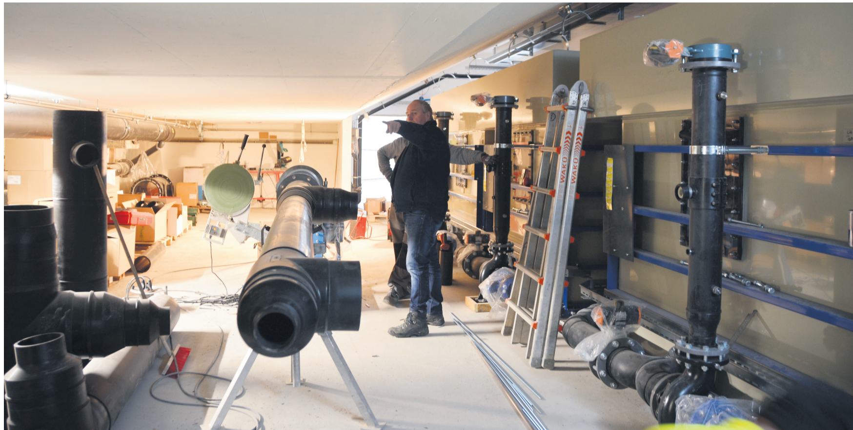
Martin Burkart im Dialog mit den Mitarbeitenden der Firma Aquila, die im Untergrund der Badi die neue Technik installieren.
