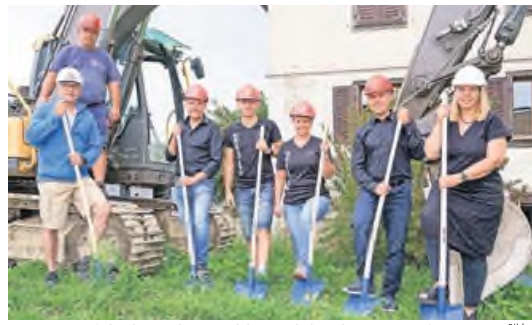
Der Spatenstich für den Neubau ist erfolgt, von links: Kilian Steger und Urim Luthishi (Hoppler AG), Roland Stöckli (Stöckli & Partner Baumanagement AG), Philipp und Jacqueline Lötscher, Daniel Christen (Stöckli & Partner Baumanagement AG) und Architektin Alexandra Schuler. Bild: zg
